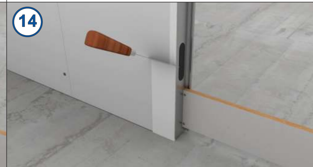
14 Szczelinę pomiędzy oknem a płytą GK wypełnij zaprawą gipsową. Na powstałym łeczeniu połóż tam flizelinę.
