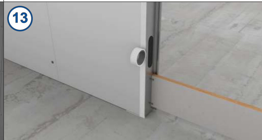
13 Szczelinę pomiędzy oknem a płytą GK wypełnij zaprawą gipsową. Na powstałym łeczeniu połóż tam flizelinę.
