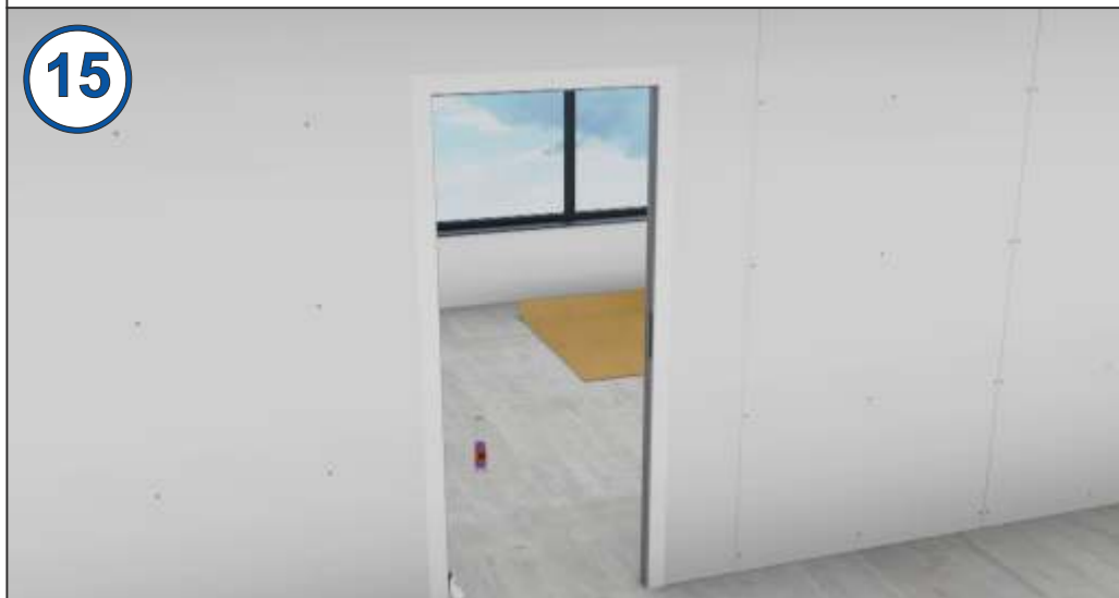
15 Odkryj poprzeczki montażowe. Następnie wykończ ścianę, oczyść i odłóż okno.
